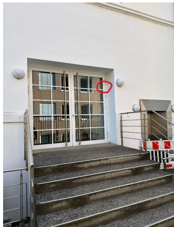
24.Punkt: Haus AXE linker Eingang UG 1
