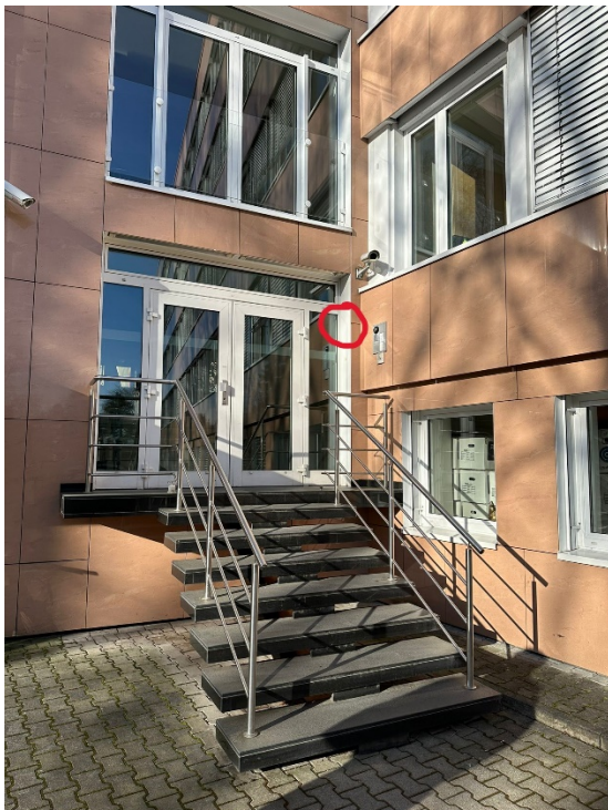
27.Punkt: Haus AXE Notausgang UG 1
