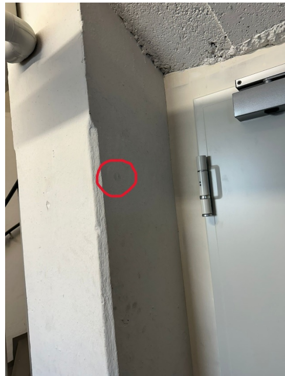
10.Punkt: Haus 4 linker Kellereingang
