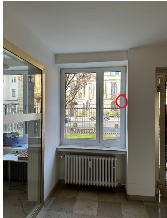
28.Punkt: Haus AXE UG 1 Serverraum
