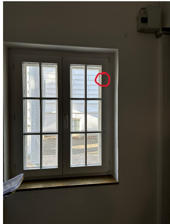
20.Punkt: Haus 2 linke Eingangstür
