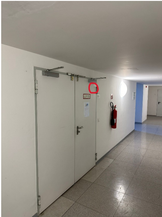
17.Punkt: Haus 3 linker Hauseingang innen am Fenster
