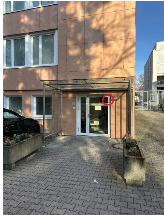
26.Punkt: Haus AXE EG Fenster am Empfang
