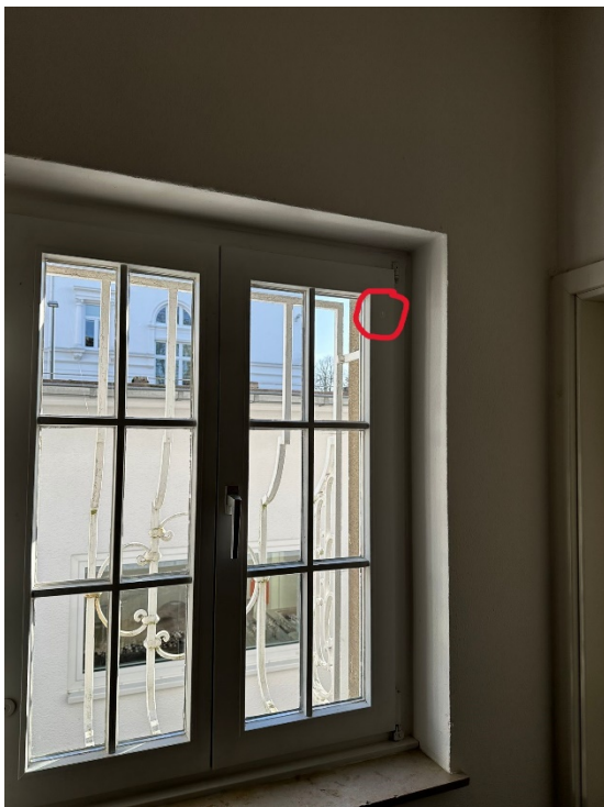
19.Punkt: 2.OG Haus 3 Herren WC
